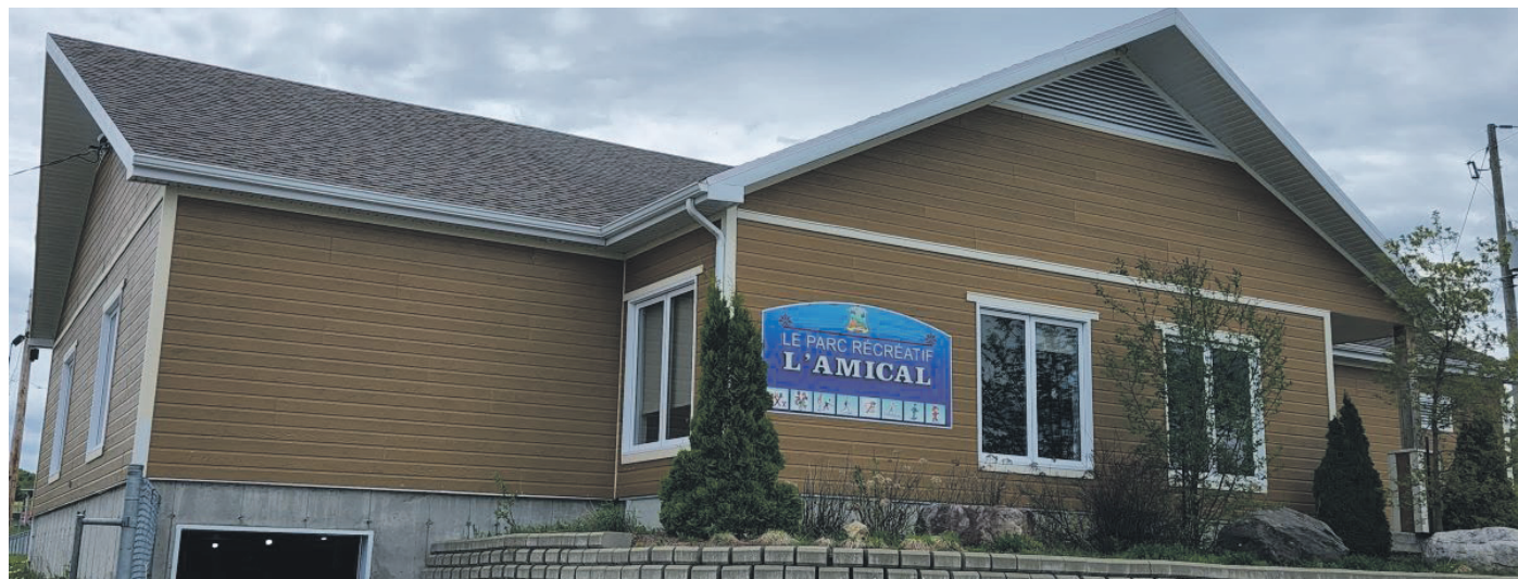
Un nouvel espace de cuisine collective sera aménagé dans le chalet des sports de Saint-Hilarion. Photo archives
