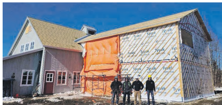
Les travaux vont bon train pour l'agrandissement du bâtiment d'accueil des Moulins de L'Isle-aux-Coudres. Photo courtoisie
