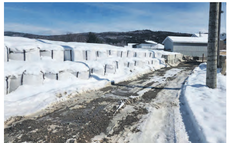
Un enrochement de 8 000 tonnes a été ajouté sur un ouvrage de protection sur la rue Ménard.
