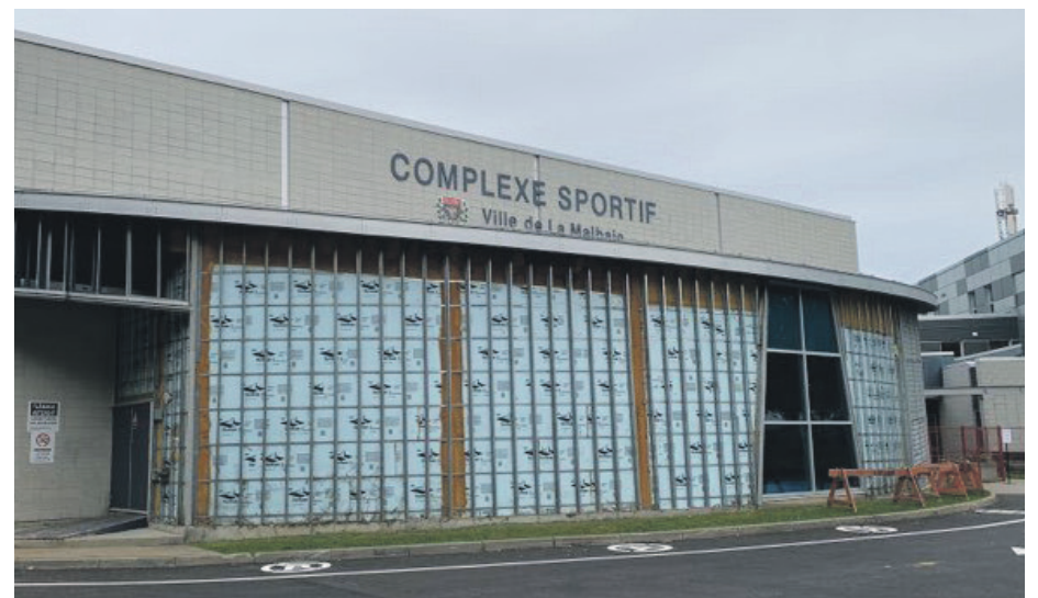
Les travaux dureront cinq semaines au Complexe sportif de La Malbaie. Photo Dave Kidd
