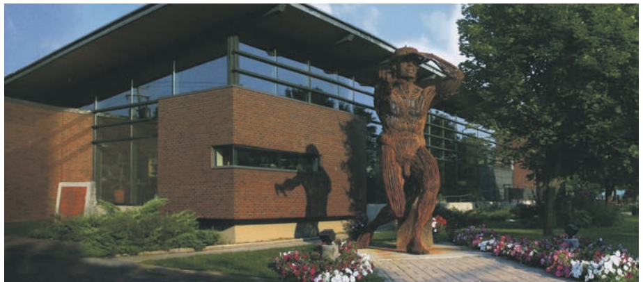
L'extérieur du bâtiment abritant la bibliothèque René-Richard et le CARC.
