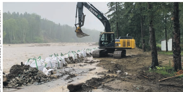
Le 11 juillet, des travaux d'urgence étaient nécessaires pour éviter une autre inondation majeure au Génévrier.
