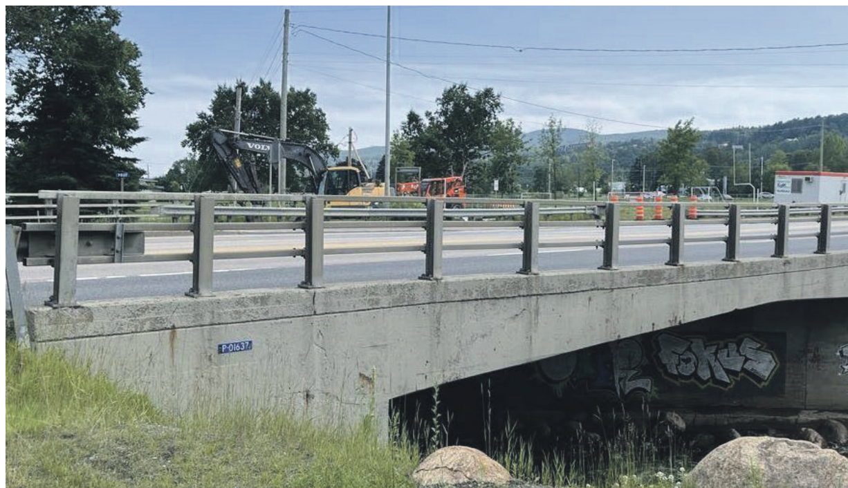
Le pont de la rivière du Bras du Nord-Ouest, sur la route 138 à Baie-Saint-Paul.
