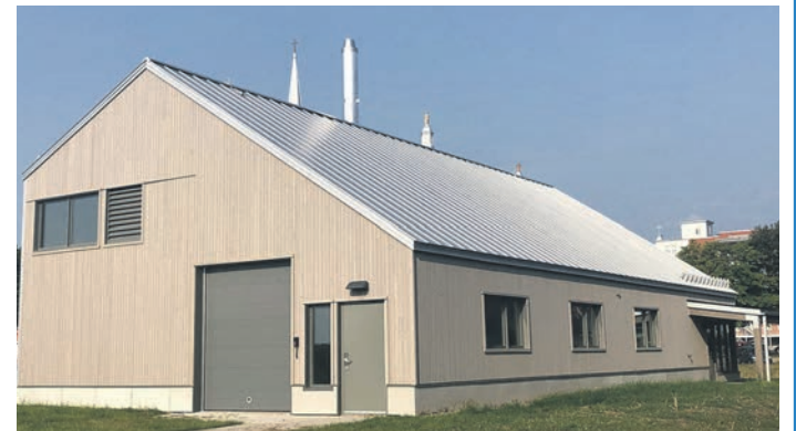
La centrale d'énergie à la biomasse forestière est située à côté de Maison Mère. Photo Ville de Baie-Saint-Paul
