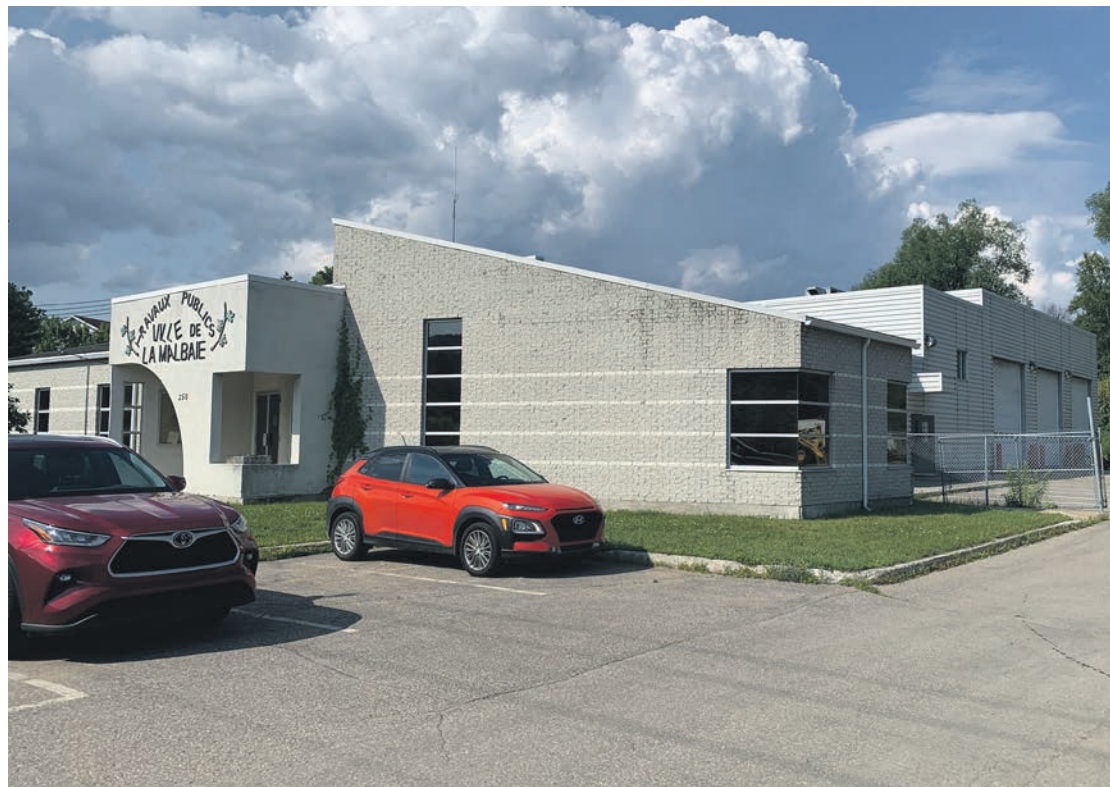
La date du début des travaux n'est pas encore précisée.
