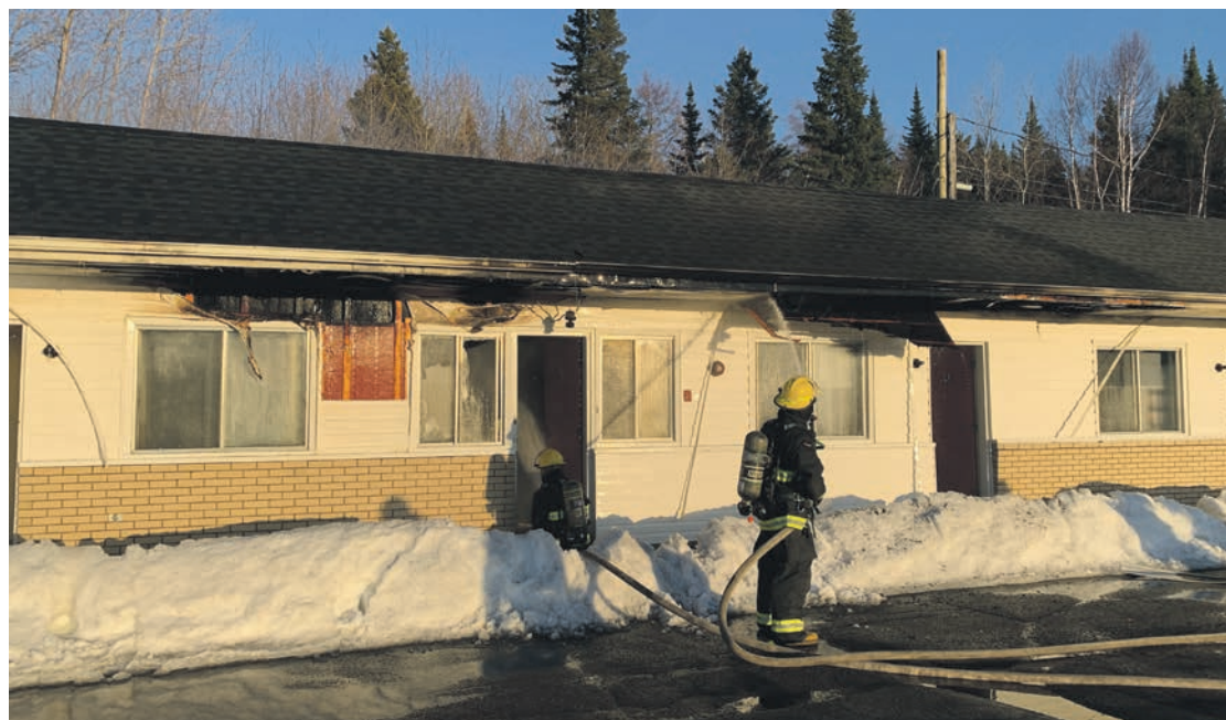
Une défectuosité électrique a allumé le brasier.
